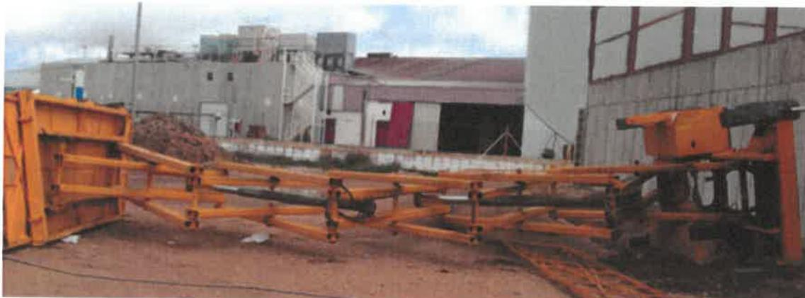
Durante las tareas de rehabilitación de la nave se ha producido un accidente por vuelco de una plataforma elevadora de personas (PEMP), tipo tijera (ver fotografía), desde la que un trabajador de la empresa contratista, soldaba una pieza metálica en un pórtico de la nave. La investigación de causas del accidente pone de manifiesto, entre otros, los siguientes hechos:
