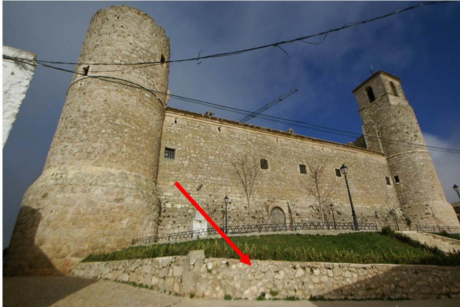
Propuesta 1. Acabado propuesto para aplacar los laterales de la rampa de hormigón existente
