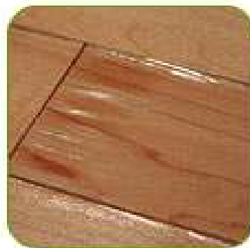
fig.2: " humedad en madera "
